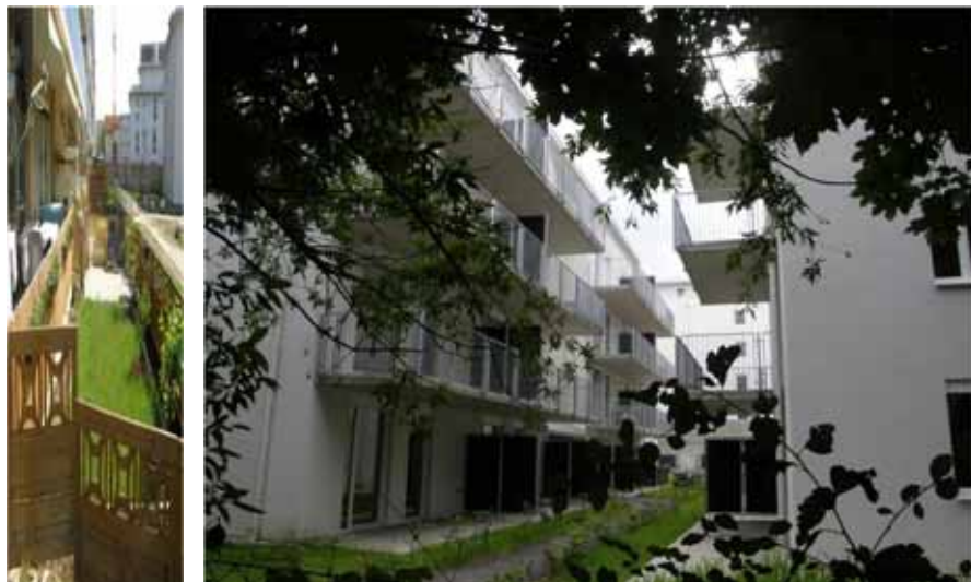
Zu geringer Gebäudeabstand, keine Privatsphäre
