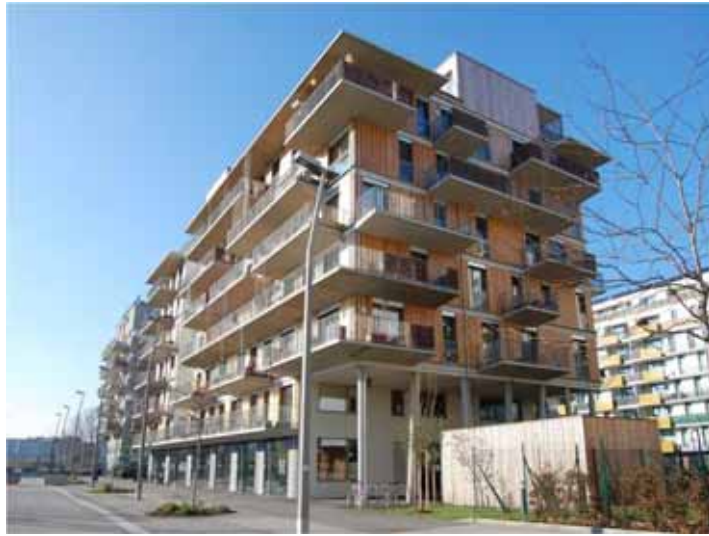
Gestalteter öffentlicher Straßen-Raum, keine EG-Wohnungen, dafür Büros, Cafes, Nahversorger
